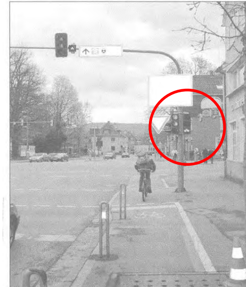
Vervoegd groen voor fietsers met vooruitgeschoven stopstreep; verkeers- en fietslichten rechts van het fietspad (Duitsland).
